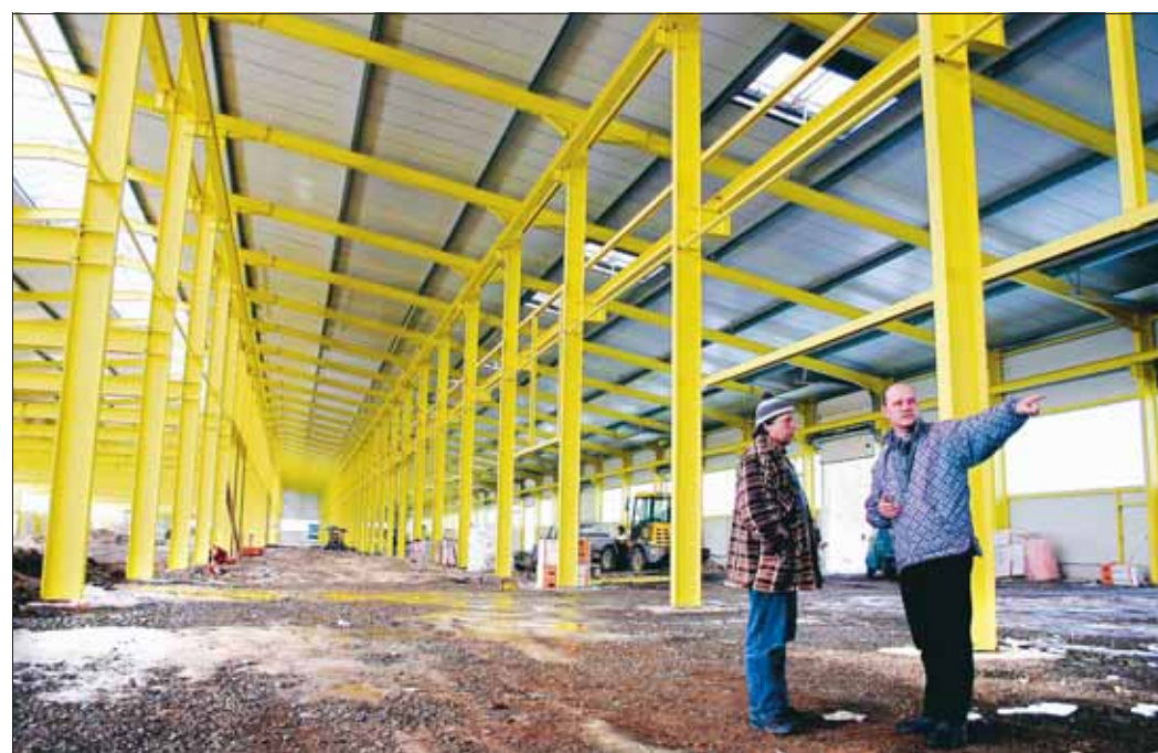
In der neuen Fliegl-Halle in Triptis-Nord beraten Projektleiter Ralf Holzmüller (r.) und Vorarbeiter Dieter Berger (l.) bautechnische Details. Obwohl das Wetter zuletzt für die Bauarbeiten nicht gerade günstig war, soll das neue Werk wie geplant Ende Mai betriebsbereit sein. (Foto: OTZ/Marius Koity)
