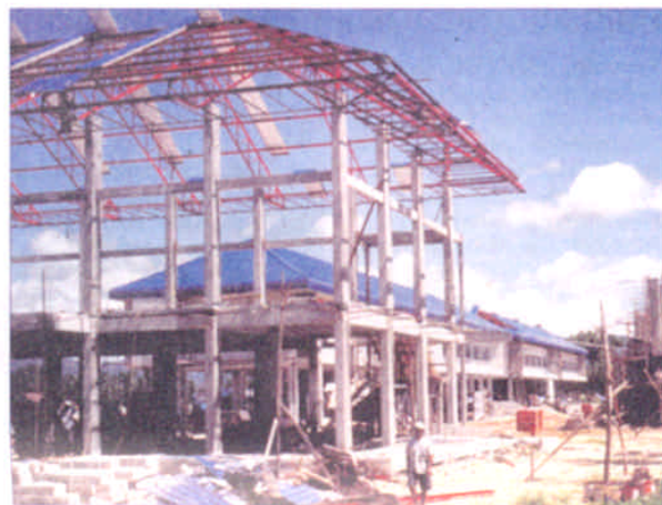
Baufortschritt an der Schule in Takua Pa
