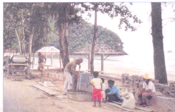
Schrittweise werden die Flutschäden in der gesamten Küstenregion beseitigt.
